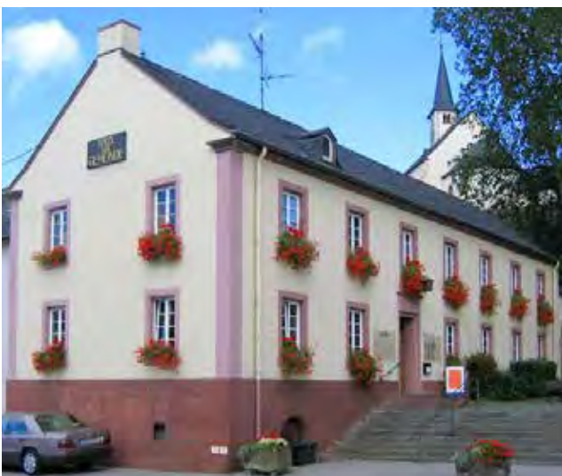
Das Gemeindehaus in Igel, in dem auch die Gemeindebücherei untergebracht ist.
